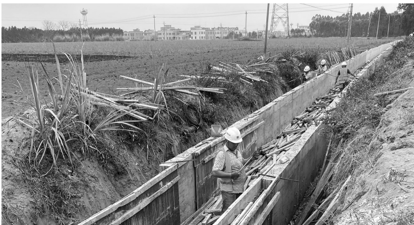
施工现场。 通讯员供图
